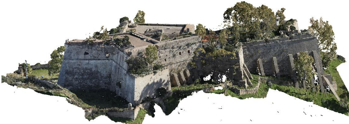
Ricostruzione del modello 3d e rilievo esterno tramite laser scanner – vista aerea lato ovest
