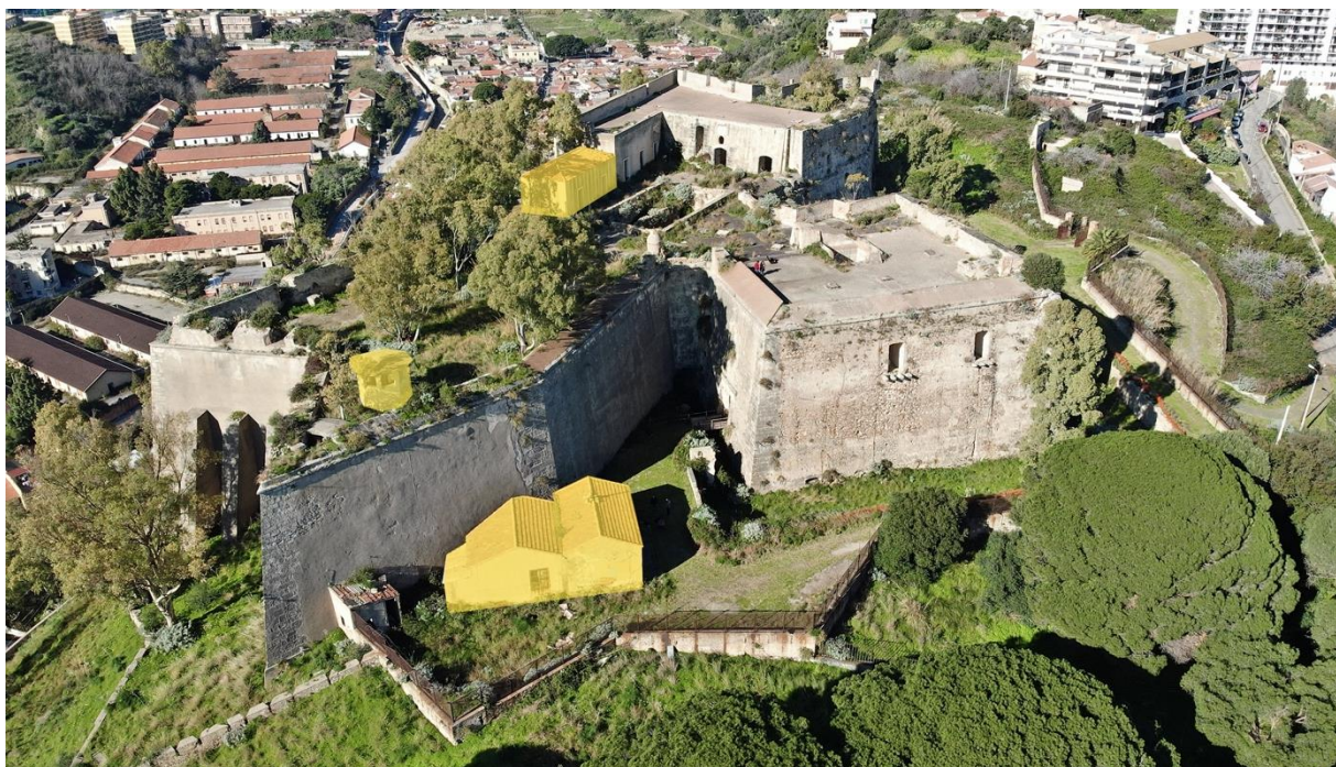
Foto aerea con individuazione delle superfetazioni da demolire
