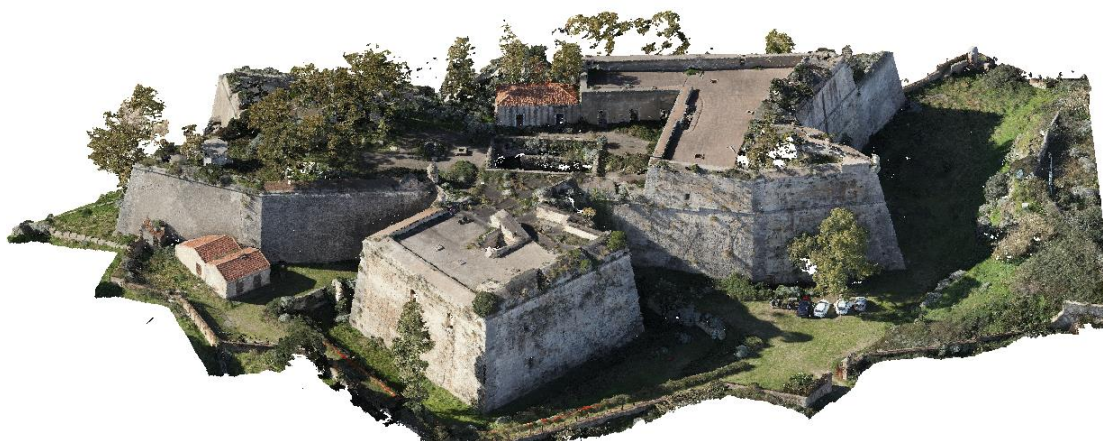
Ricostruzione del modello 3d e rilievo esterno tramite laser scanner – vista aerea lato est
