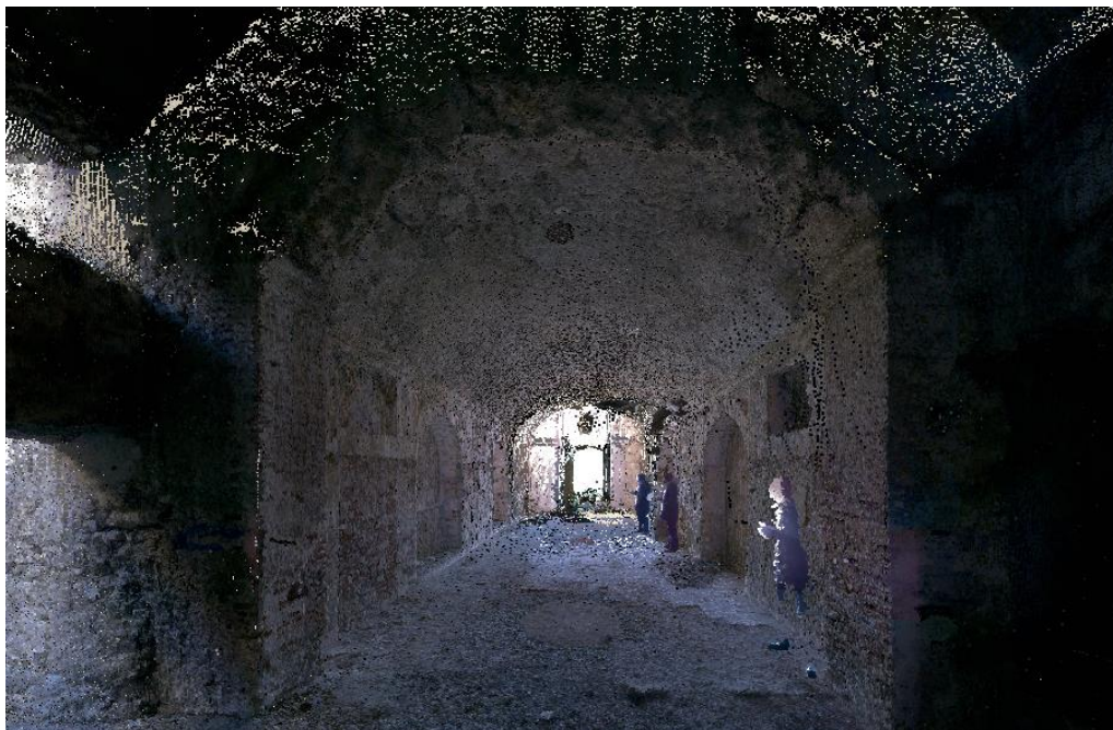
Ricostruzione del modello 3d e rilievo interno tramite laser scanner – Ex Cappella
